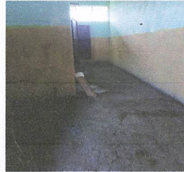
FOTO 2: DURANTE LA COLOCADA DE PISO BAÑO
