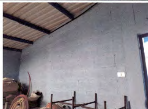
Foto 4: Repello y cernido de las paredes de la bodega.
