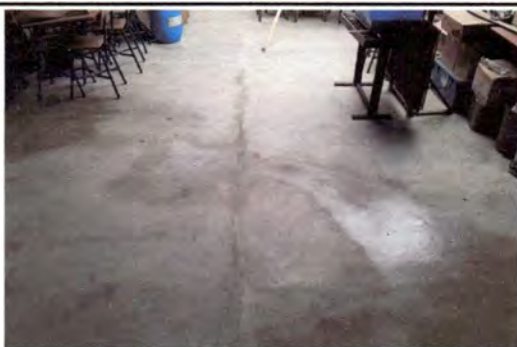
Foto 5: Cambio de piso de la bodega.
