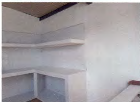
Foto1: Repello y cernido de las paredes de la cocina.
