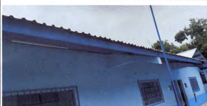
Foto 9: Canales para bajadas de agua.
