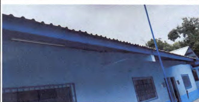
Foto 9: Canales para bajadas de agua.
