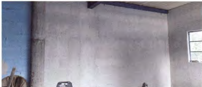
Foto1: Repello y cernido de las paredes de la cocina.
