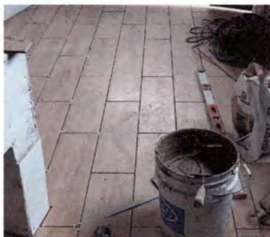
Foto 2: Cambio de piso de la cocina.
