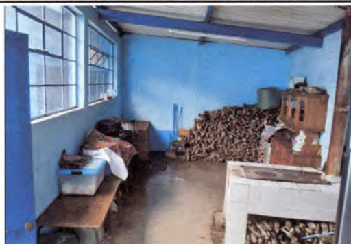
Foto 2: Cambio de piso de la cocina.
