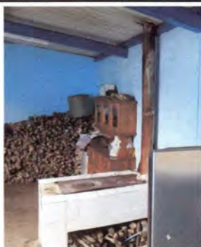
Foto 3: Reparación de la chimenea y plancha de la cocina.
