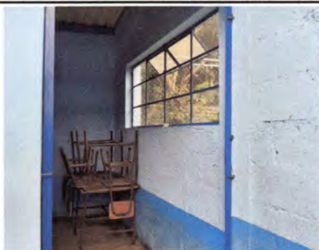
Foto1: Repello y cernido de las paredes de la cocina.
