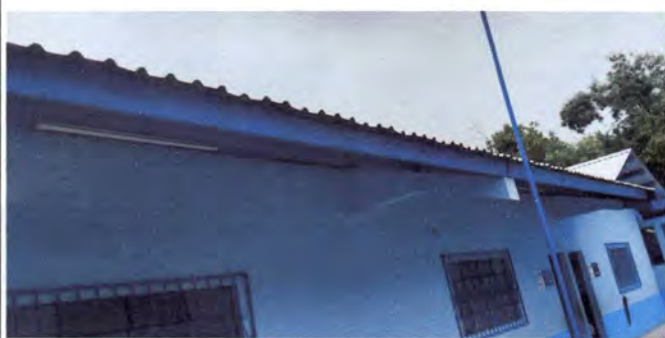
Foto 9: Canales para bajadas de agua.
