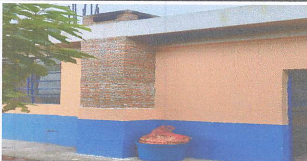
Foto 5: Chimenea: Construcción de Chimenea de ladrillo en la cocina del establecimiento.
