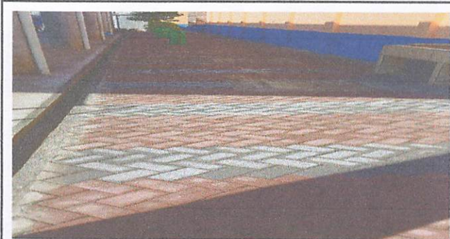
Foto 10: Colocación de baldoquín en el pasillo del polideportivo del establecimiento
