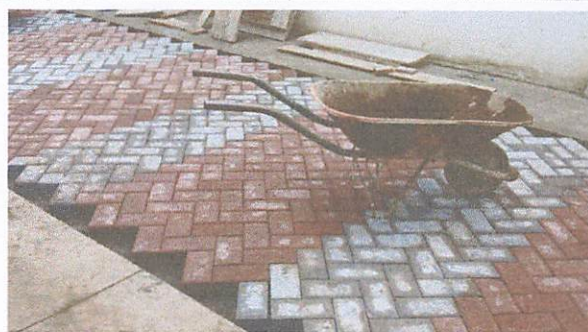
Foto 10: Colocación de baldosín en el pasillo del polideportivo del establecimiento.
