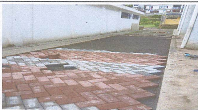
Foto 9: Colocación de baldosín en el pasillo del polideportivo del establecimiento.
