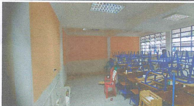
Foto 3: Pintura de paredes interiores: Cambio de pintura de los salones de clases.
