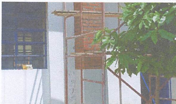
Foto 5: Chimenea: Construcción de Chimenea de ladrillo en la cocina del establecimiento.
