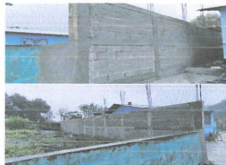
Foto 4: Muro Perimetral concluido
