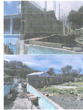
Foto: 4 Realizando el muro perimetral
