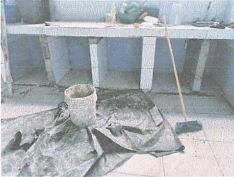
Foto: 1 Albañiles trabajando en las divisiones para formar los gabinetes
