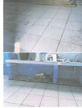
Foto: 2 colocando piso antideslizante en cocina y bodega
