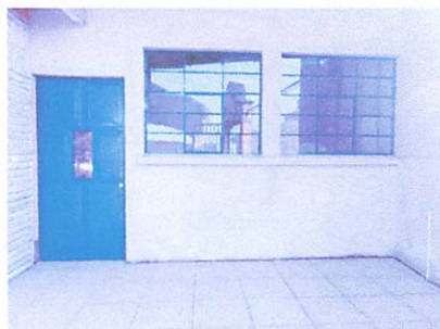
FOTO 2: sustitución de ventanas de cocina
