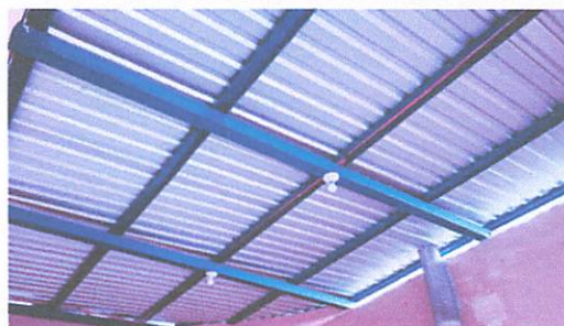
FOTO 6: SUSTITUCIÓN Y REPACIÓN DE TECHO CON VIGAS DE METAL
