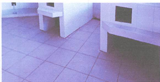
FOTO 3: SUSTITUCIÓN DE PISO BALDOQUIN, POR PISO CERAMICO ANTIDESLIZANTE
