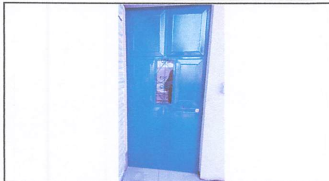
FOTO 7: SUSTITUCIÓN DE PUERTA DE LÁMINA POR PUERTA DE METAL
