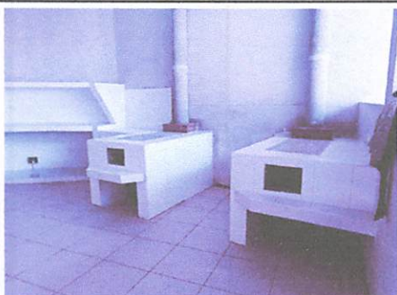
FOTO 5: REPARACIÓN O SUSTITUCIÓN DE AREA DE COCINA POR PLANCHAS Y CHIMENEA
