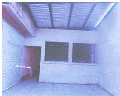
FOTO 2: sustitución de ventanas de cocina
