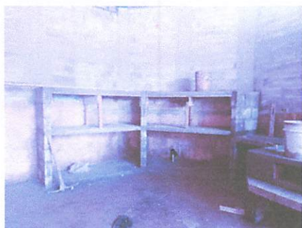
FOTO 9: SUSTITUCIÓN POR MESAS DE CONCRETO+AZULEJO+PUERTA
