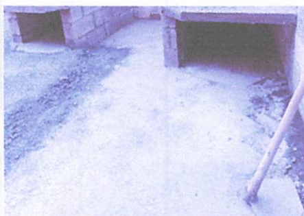
FOTO 3: SUSTITUCIÓN DE PISO BALDOQUIN, POR PISO CERAMICO ANTIDESLIZANTE
