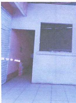
FOTO 7: SUSTITUCIÓN DE PUERTA DE LÁMINA POR PUERTA DE METAL
