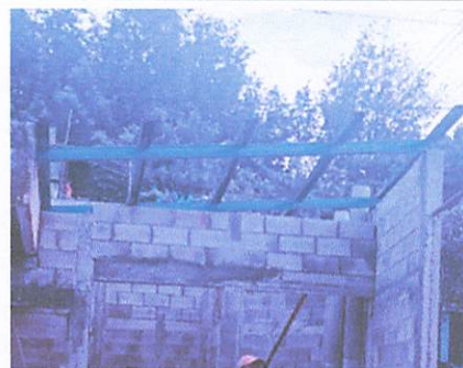
FOTO 6: SUSTITUCIÓN Y REPACIÓN DE TECHO CON VIGAS DE METAL
