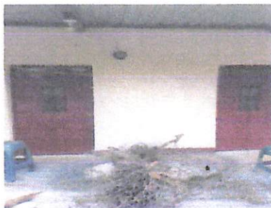
Foto 5: puertas de metal instaladas
