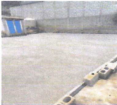
Foto 1: fundicon de patio terminada
