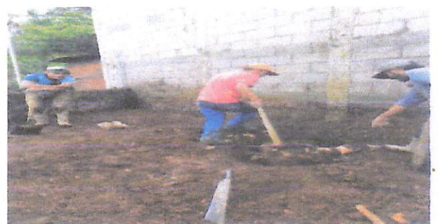
Foto: Sacado de tierra para fundición de patio
