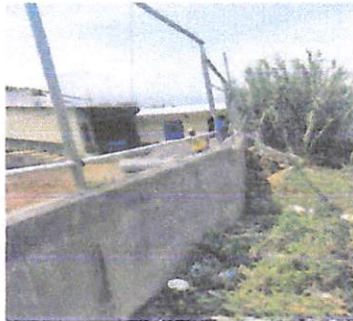
Foto: colocación de malla en muro perimentral
