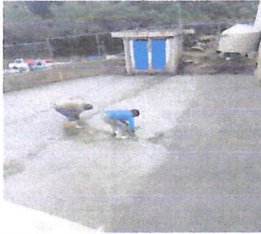
Foto; paviemntación de patio
