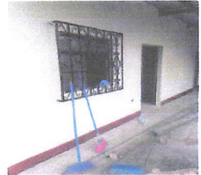
Foto: pintura en paredes
