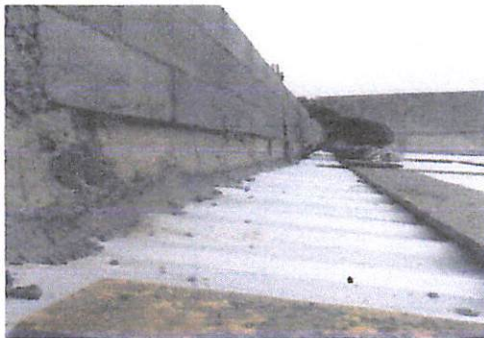
Foto: Colocación de lámina
