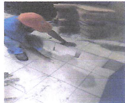
Foto: colocación de piso cerámico
