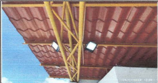
Foto 7: Remozamiento de energía eléctrica, colocación de 6 reflectores blancos. Módulo 3
