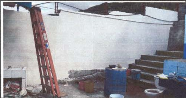
Foto 5: Colocación de cubierta de repello en paredes del establecimiento. 60 metros lineales. Módulos 1, 2 y 3.
