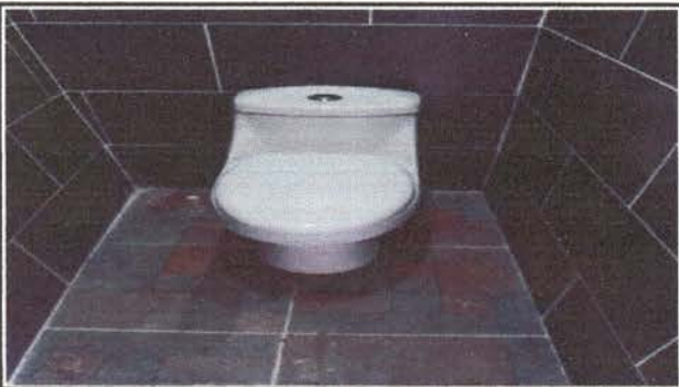
Foto 3: Remozamiento de 10 sanitarios para servicio de los alumnos y docentes. Remozamiento de piso cerámico en sanitarios y cambio de repello por azulejo cerámico. Módulos 1 y 3
