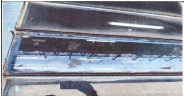
Foto 6: Remozamiento de vidrios en 3 módulos. 45 unidades de 18 por 51 centímetros.
