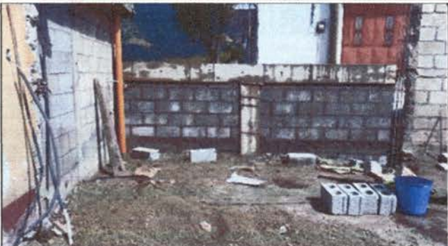
Foto 1: Remozamiento de muro de contención, esto debido al colapso de muro perimetral. 18 metros lineales. Módulo 3
