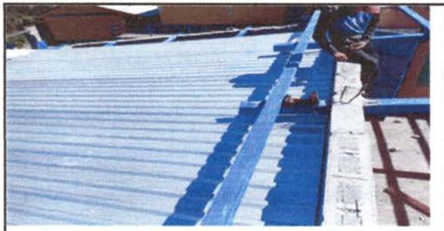
Foto 8: Colocación de techo módulo 3 aula 4.
