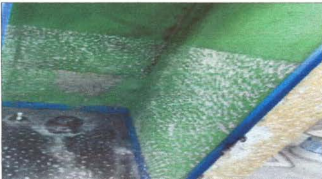
Foto 3: Remozamiento de 10 sanitarios para servicio de los alumnos y docentes. Remozamiento de piso cerámico en sanitarios y cambio de repello por azulejo cerámico. Módulos 1 y 3
