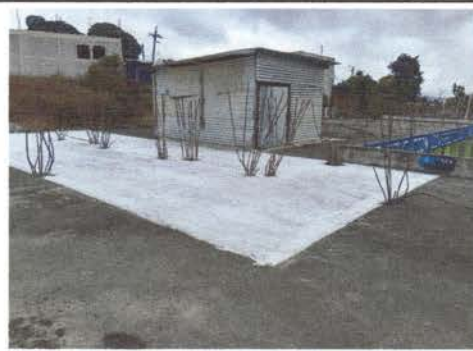
Foto 4: Finalización de la impermeabilización de la loza donde filtra el agua en tiempo de invierno
