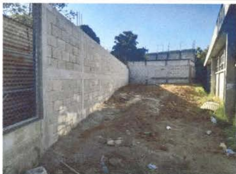
Foto 1: Muro perimetral finalizado
