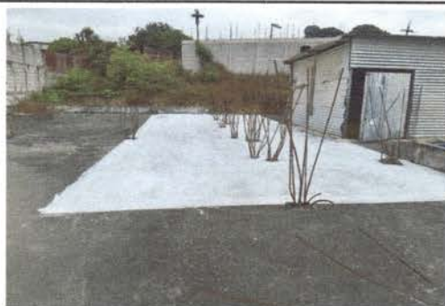
Foto 5: Impermeabilización de la parte de la loza ya finalizado
