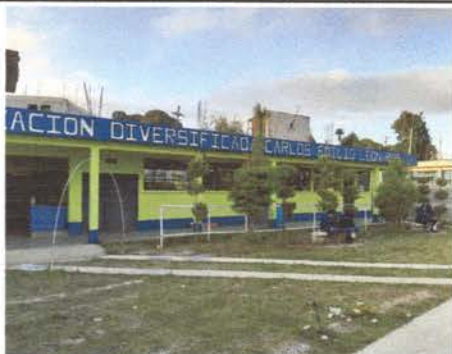
Foto1: Vista frontal de un ala del edificio escolar ya pintado en su totalidad
