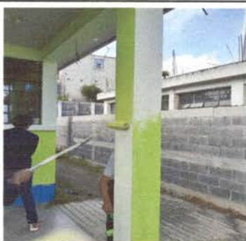
Foto 5: Pintando las paredes exteriores del edificio escolar
