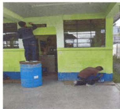
Foto 4: Iniciando a pintar las paredes internas y externas del edificio escolar
