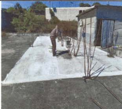
Foto 3: Impermeabilización de la loza donde filtra el agua en el salón de clases en tiempo de invierno
