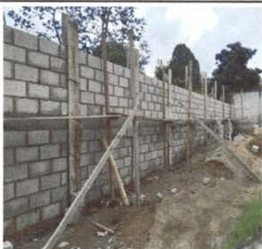
Foto 3: Fundiendo las columnas del muro perimetral en construcción.
