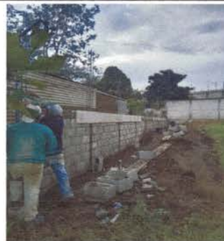
Foto 2: Colocando tablas para fundir soleras del muro perimetral.
