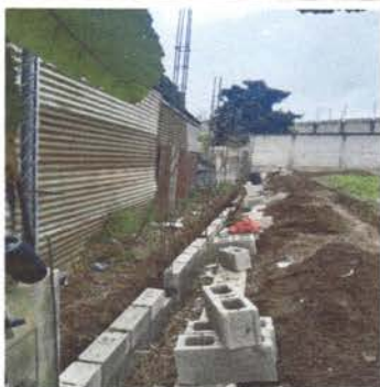
Foto1: Avance de la construcción del muro perimetral del predio donde se ubica el establecimiento educativo.
