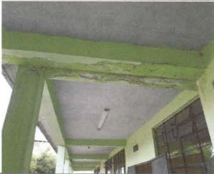
Foto 7: Parte de la loza a impermeabilizar
