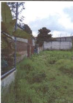
Foto 1: Área donde se requiere construir muro perimetral
