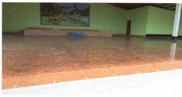
Foto 3: Pintada de las paredes de la escuela
