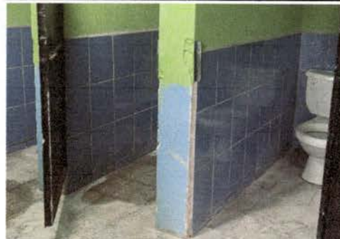
Foto 4: Mantenimiento de baños de los niños
