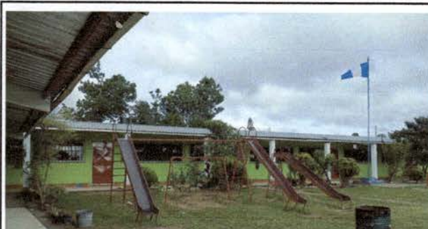
Foto 2: Cambio de pintura de las paredes
