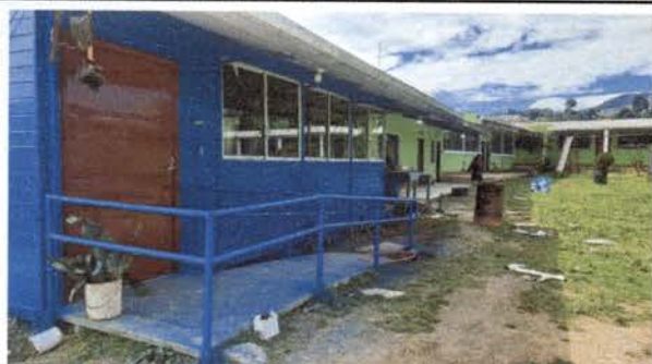
Foto1: Paredes de los salones de clase que se pintaron
