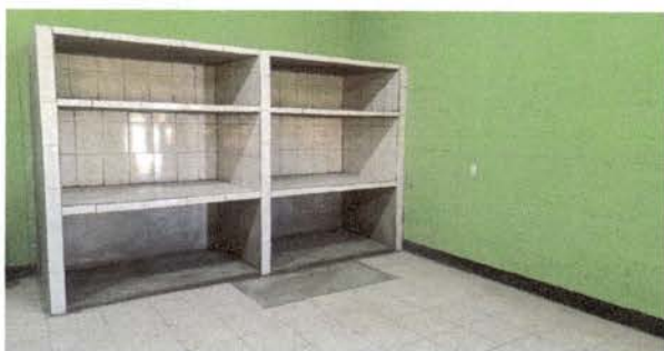
Foto 5: Construcción de estante de la cocina
