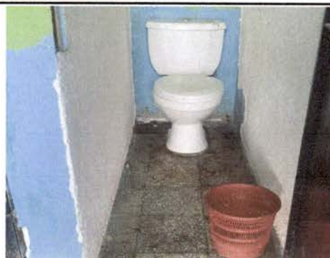
Foto 4: Mantenimiento de baños de los niños
