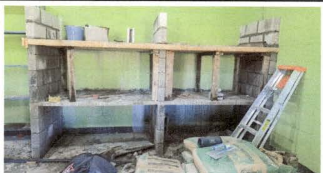
Foto 5: Construcción de estante de la cocina
