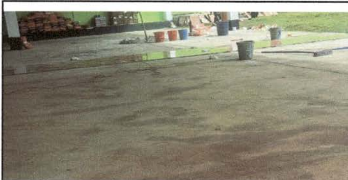
Foto 6: Puesto del piso sobre la torta del salon de usos multiples
