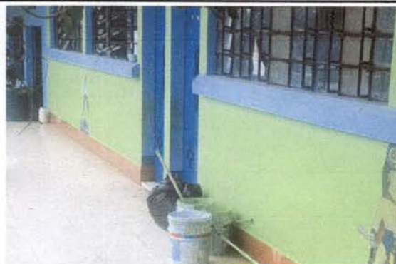
Foto 2: Cambio de pintura de las paredes
