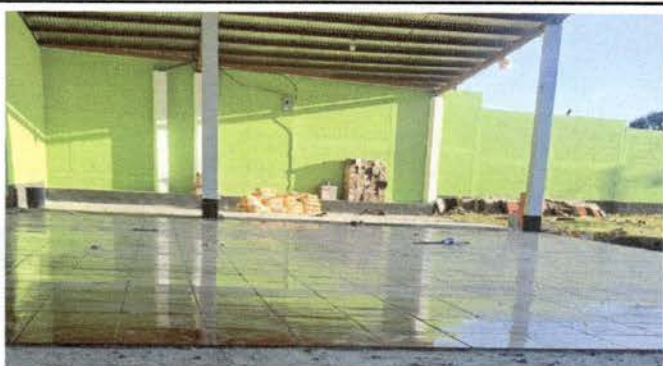
Foto 3: Pintada de las paredes de la escuela
