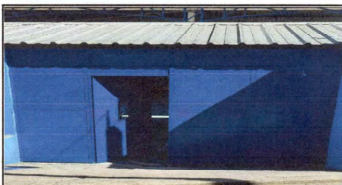
Foto 4: Cambio de portón
