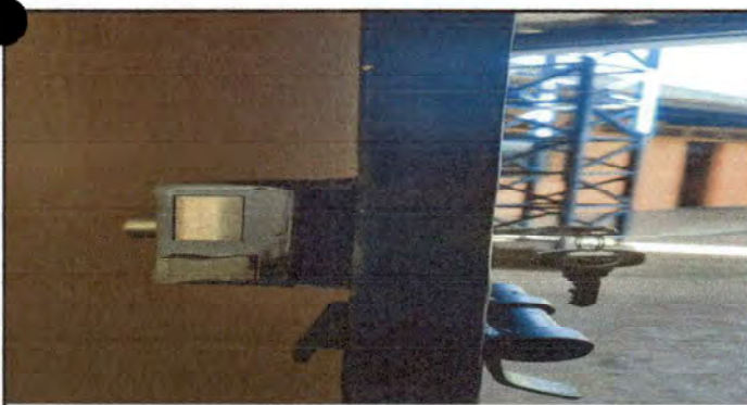
Foto 5: Mantenimiento a puertas: cambia de chapas
