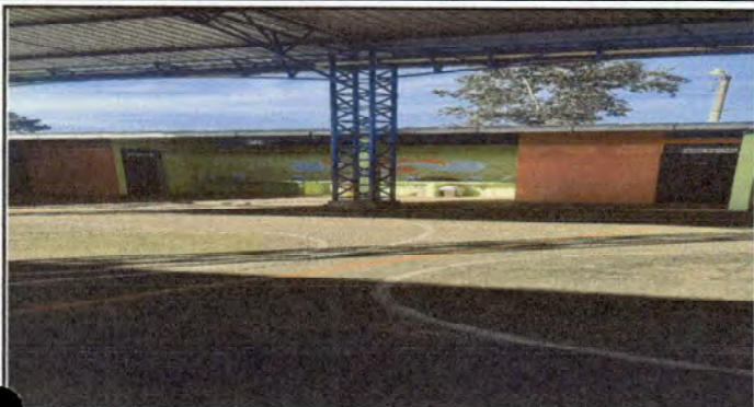
Foto 1: Pintura en muros interiores y exteriores
