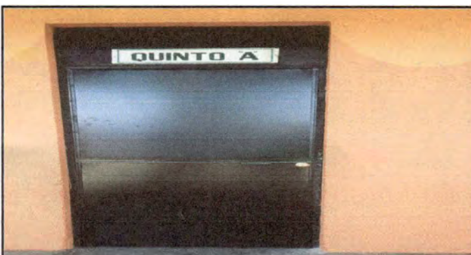
Foto 3: Cambio de puertas
