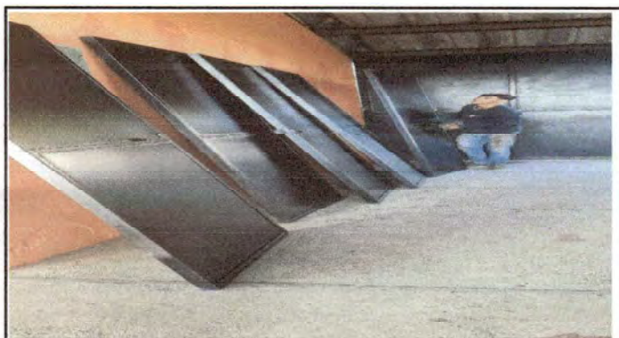
Foto 3: Cambio de puertas
