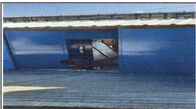
Foto 4: Cambio de portón
