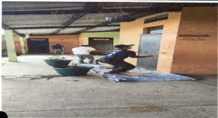
Foto1: Pintura en muros interiores y exteriores
