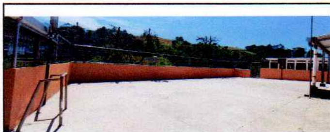
Foto 5: Muro de mampostería instalada y reparada
