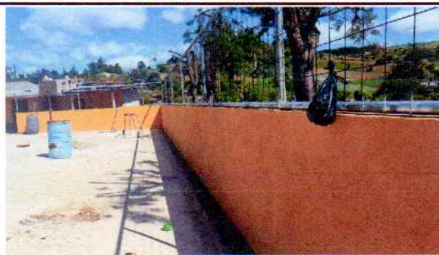
Foto 3: Reparación de muro de contención interna finalizada
