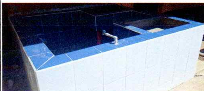
Foto 2: Pila con 2 lavaderos
