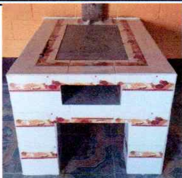
Foto1: Reparación de estufa rural -POYETÓN- finalizada
