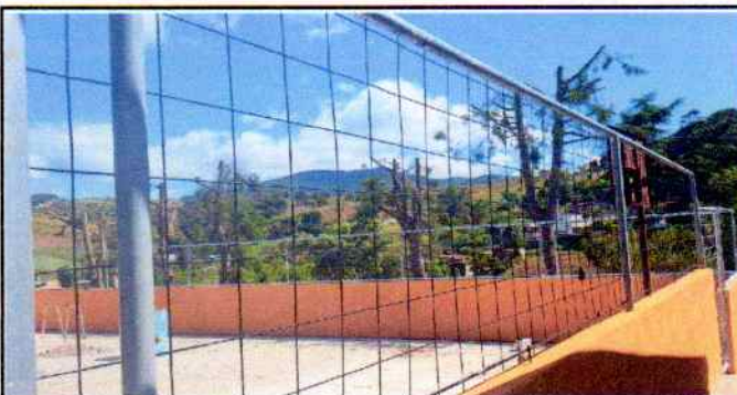
Foto 6: Instalación de electromalla finalizada
