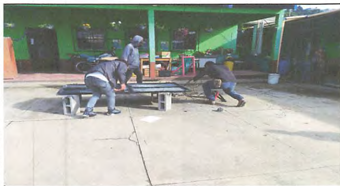
Foto 15: corte de puertas por colocación de piso
