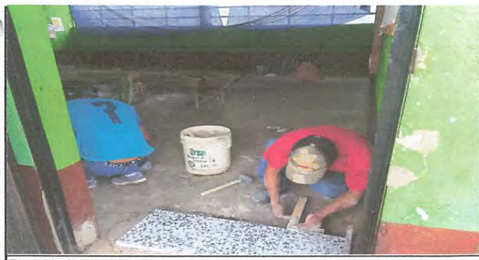
Foto 11: Inicio de colocacion de piso de granito . En Preprimara A
