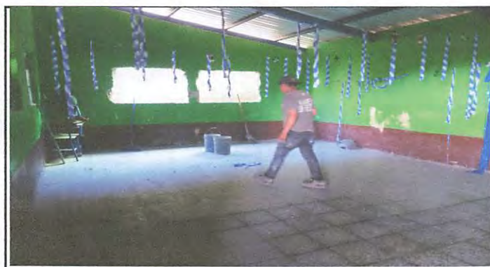
Foto 9: avance de Apertura de ventana en la pared del fondo y colocacion de piso de granito En quinto grado B.
