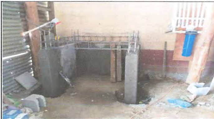
Foto 2: Levantado de pared y primeras armaduras.
