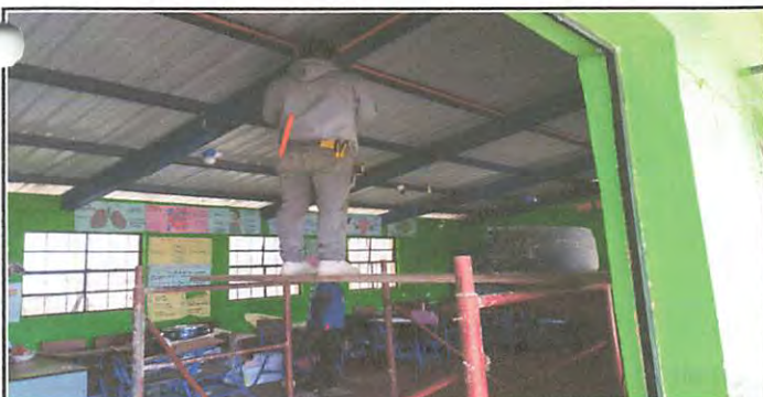
Foto 5: Colocación de cables electricos dentro de ducto para resguardar la integridad fisica de alumnos.
