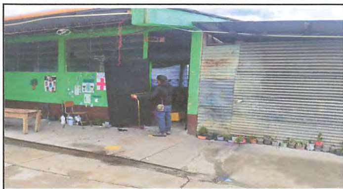
Foto 16: instalación de puertas por colocación de piso
