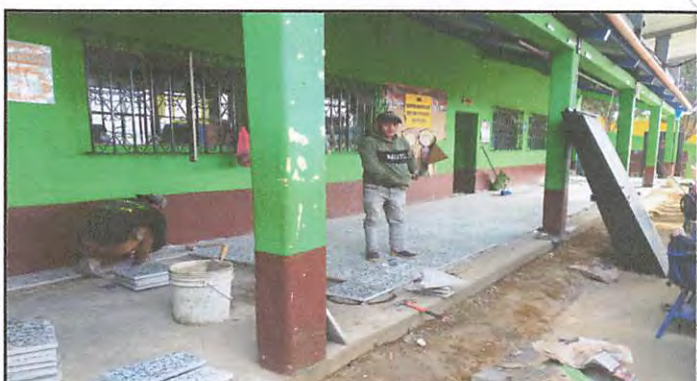
Foto 10: avance de colocacion de piso de granito . En corredor de patio A.
