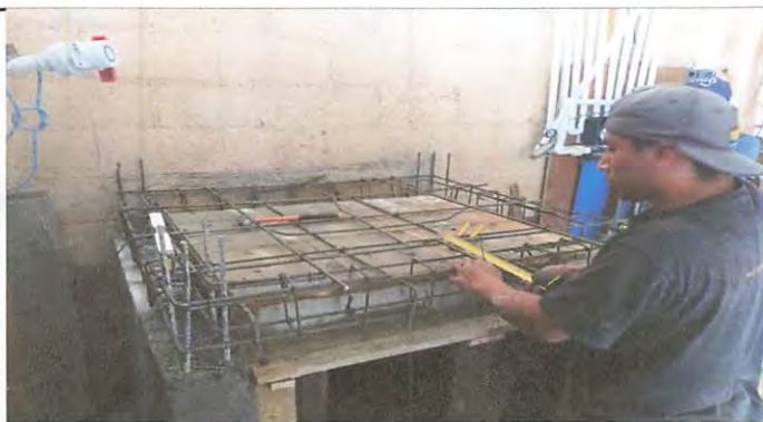
Foto 3: armadura y formaleta( encofrado) de deposito de agua.
