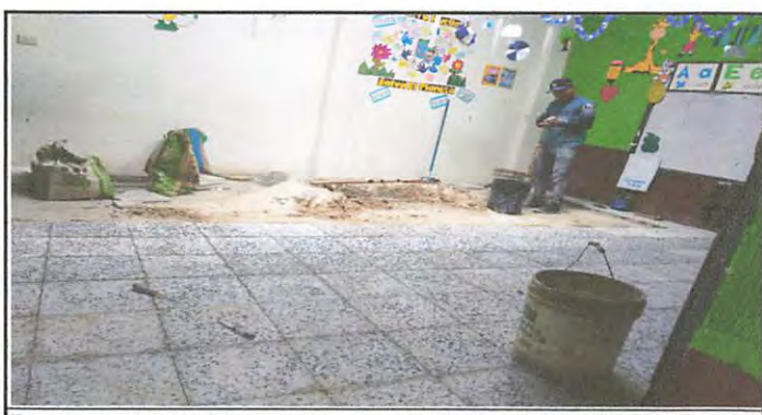
Foto 12: avance de colocacion de piso de granito . En Preprimara B.
