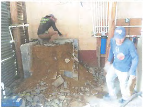
Foto 1: Preparando el area para la base de deposito de agua (tinaco)
