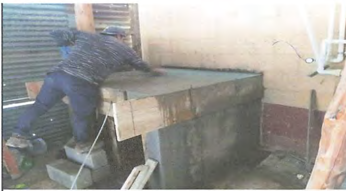
Foto 4: Fundiendo la base de deposito de agua.
