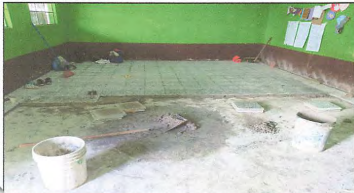
Foto7: Avance de colocación de piso En quinto grado A
