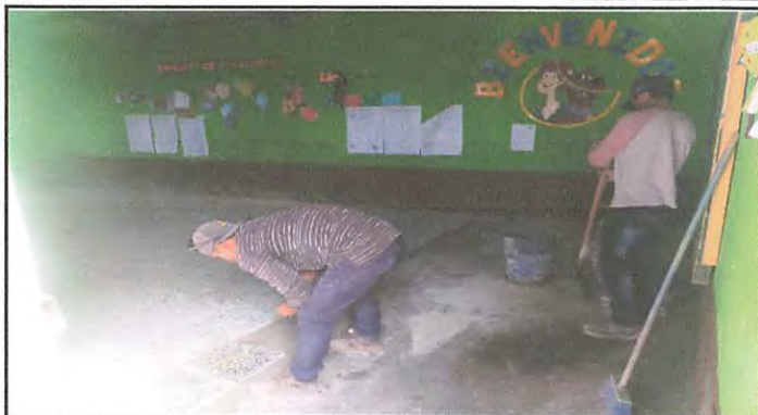
Foto 8: Avance de colocación de piso Primer grado A.
