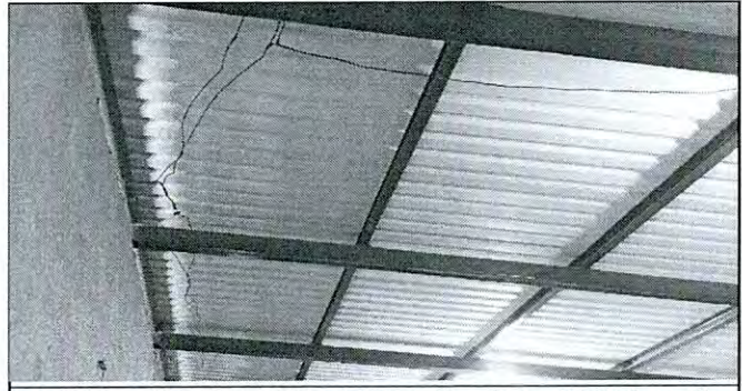
Foto 6: Los cables de conducto electrico estan sin recubrimiento en 12 ambientes diferentes los cuales se les pondradentro de ductos para asegurars la integridad de niños y docentes.
