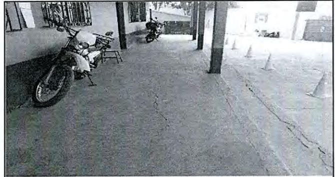
Foto 10: colocacion de piso en el corredor ya que el existente es solo de cemento. En corredor de patio A.
