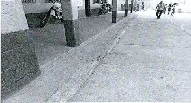
Foto 13: Banqueta con muchas fisuras en todo el largo.
