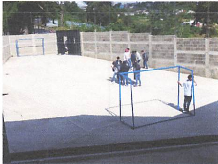
Foto 3: CIRCULACIÓN Y PAVIMENTACIÓN DEL ESTABLECIMIENTO TERMINADA.
