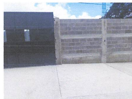
Foto 4: CIRCULACIÓN Y PAVIMENTACIÓN DEL ESTABLECIMIENTO TERMINADA.
