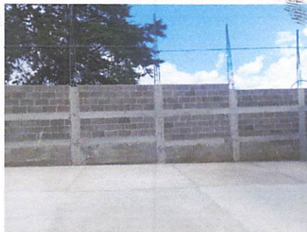
Foto 5: CIRCULACIÓN Y PAVIMENTACIÓN DEL ESTABLECIMIENTO TERMINADA.
