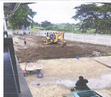
Foto 6: PAVIMENTACIÓN DEL ÁREA DEL PARQUEO
