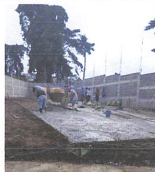
Foto 2: PAVIMENTACIÓN EN EL ÁREA DE PARQUEO
