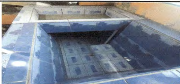
Foto 5: Finalización de pila
