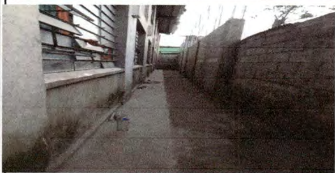
Foto 1: Finalización Muro de concreto
