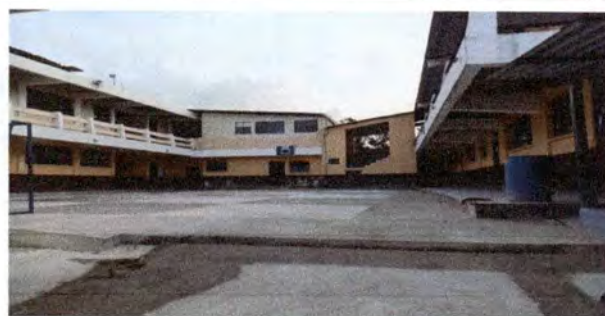
Foto 4: Proceso del patio de concreto
