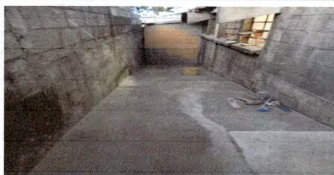
Foto 2: Pavimentación entrada a muro perimetral
