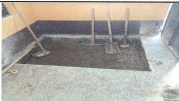
Foto7: Durante construcción de pila
