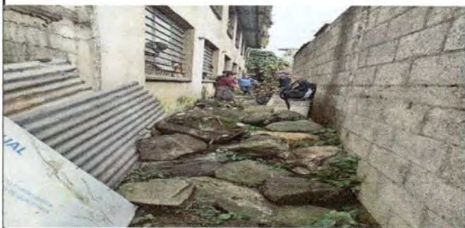
Foto 1: Durante muro perimetral
