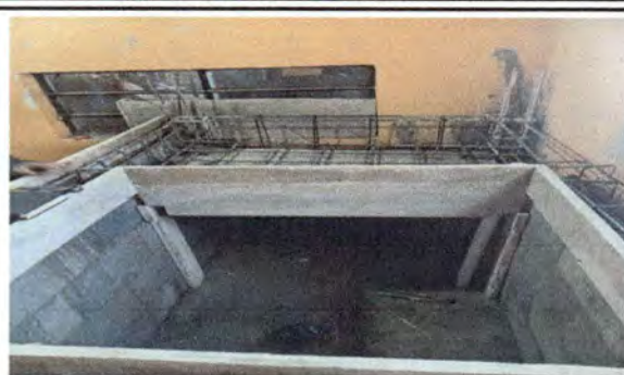
Foto 8: Construcción de Pila
