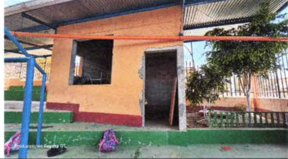
puerta de bodega que se le dará mantenimiento
