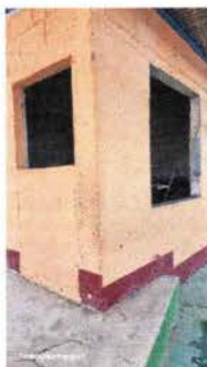
Ventana frontal y lateral de bodega
