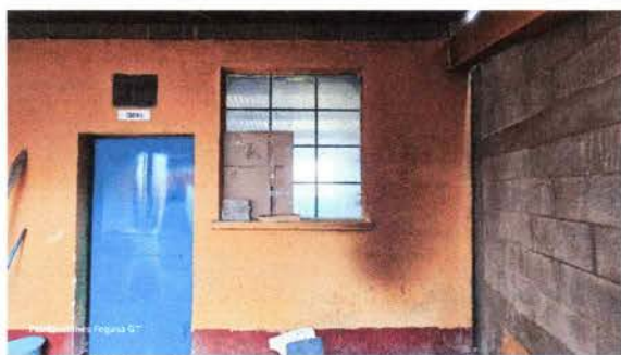
Ventana frontal de cocina
