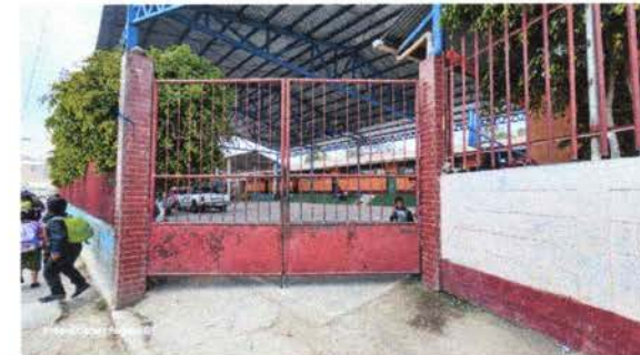
porton de la calle que se le dará mantenimiento
