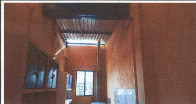
Foto 3: DEMOLISION DE PARED PARA AMPLIAR ESPACIO Y DEMOLISION DE TOP DE COCINA POR MAL ESTADO
