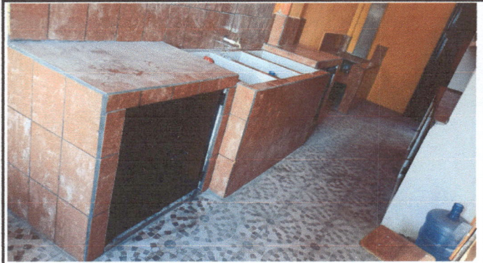
Foto 2: DEMOLISION DE GRADAS, ESPACIO QUE SERVIRA PARA EL OTRO POLLETÓN Y PUERTA EN MAL ESTADO.
