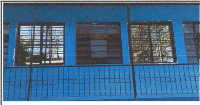
Foto 6: VENTANAS EN MAL ESTADO Y QUE NO PERMITEN LA VENTILACION DEL ESPACIO Y SE NECESITA PINTAR ESTE ESPACIO, POR DENTRO Y FUERA.
