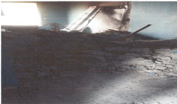
Foto 3: DEMOLISION DE PARED PARA AMPLIAR ESPACIO Y DEMOLISION DE TOP DE COCINA POR MAL ESTADO
