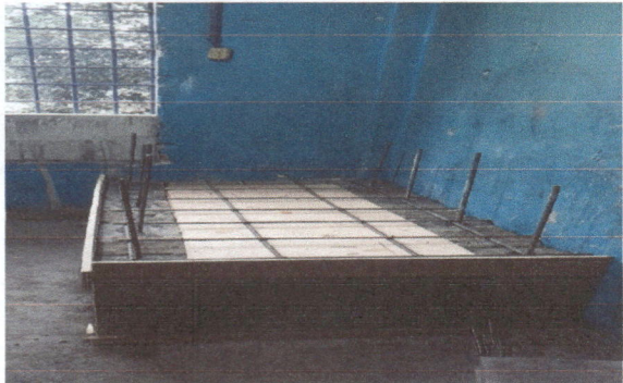
Foto 1: Construcción del nuevo polletón
