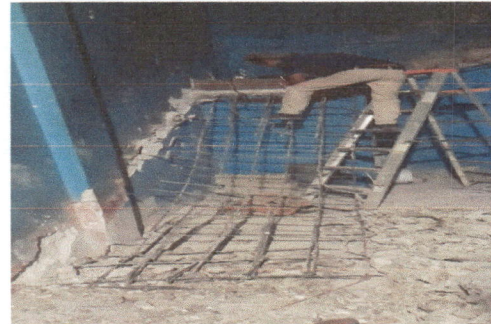
Foto 2: DEMOLISION DE GRADAS, ESPACIO QUE SERVIRA PARA EL OTRO POLLETÓN Y PUERTA EN MAL ESTADO.
