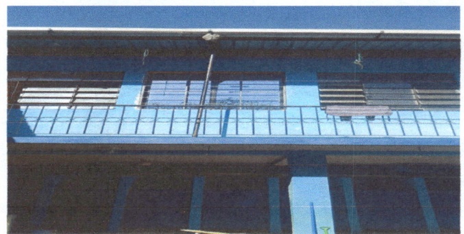
Foto 6: VENTANAS EN MAL ESTADO Y QUE NO PERMITEN LA VENTILACION DEL ESPACIO Y SE NECESITA PINTAR ESTE ESPACIO, POR DENTRO Y FUERA.
