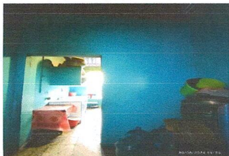
Foto 3: DEMOLISION DE PARED PARA AMPLIAR ESPACIO Y DEMOLISION DE TOP DE COCINA POR MAL ESTADO
