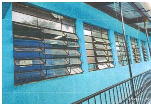
Foto 6: VENTANAS EN MAL ESTADO Y QUE NO PERMITEN LA VENTILACION DEL ESPACIO Y SE NECESITA PINTAR ESTE ESPACIO, POR DENTRO Y FUERA.
