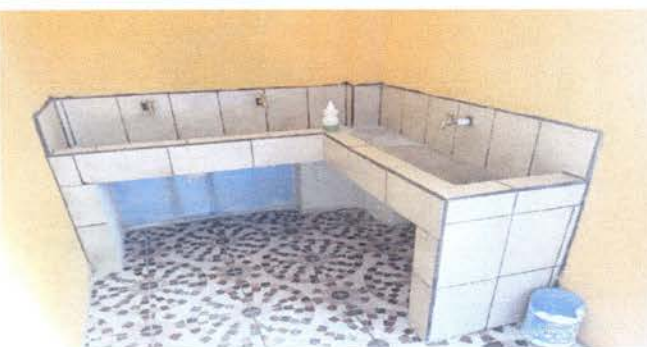
Foto 3: Base de concreto para lavamanos azulejada
