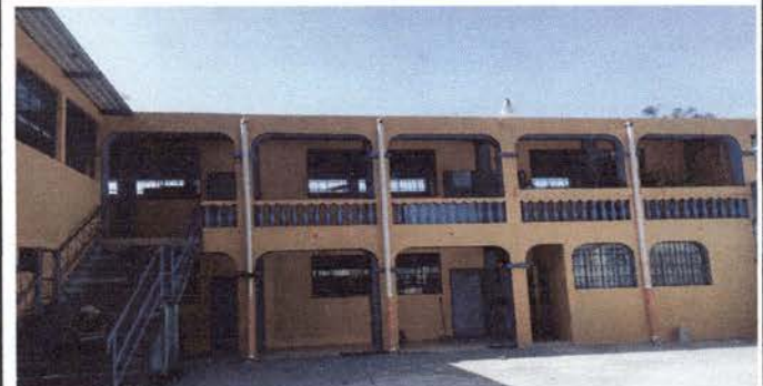
Foto 12: Pintura aplicada en el exterior de la escuela
