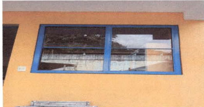
Foto 4: Ventana de cocina instalada
