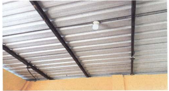
Foto 8: Instalación de plafoneras con su foco
