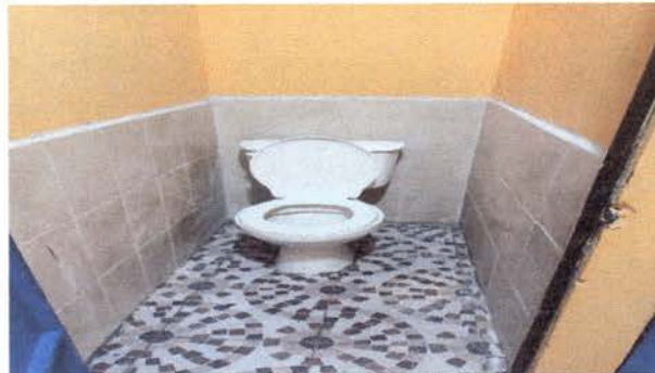
Foto 2: Cambio de accesorios de sanitarios, piso antideslizante y paredes azulejados
