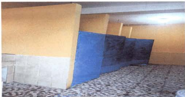
Foto 1: Puertas reparadas y pintadas
