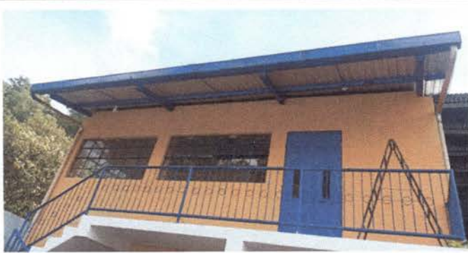
Foto 9: Canal de estructura metálica colocado con sus respectivos cargadores
