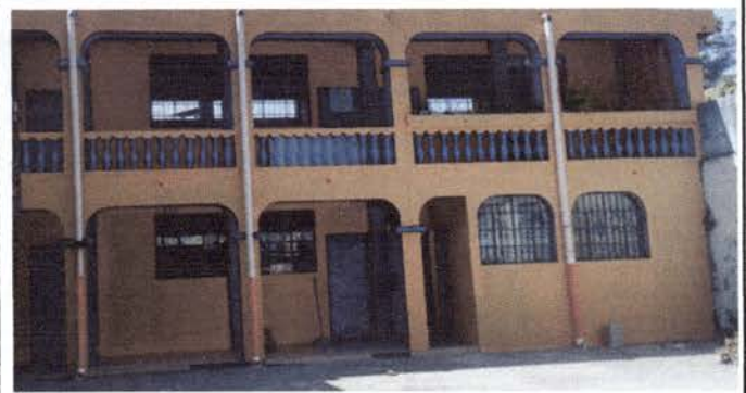
Foto 10: Bajadas de agua pluvial arregladas
