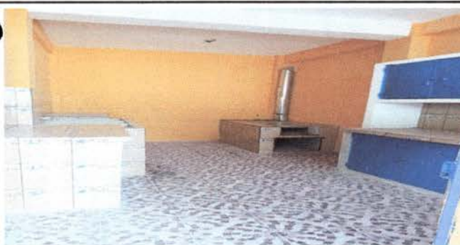
Foto 5: Instalación de piso antideslizante y azulejos en gabinete y pila.
