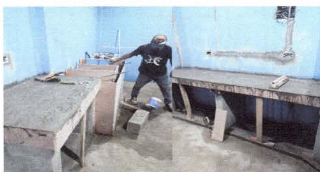
Foto 5: Fabricación de Gabinete de cocina y pila de concreto
