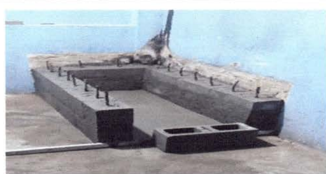
Foto 6: Fabricación de estufa rural
