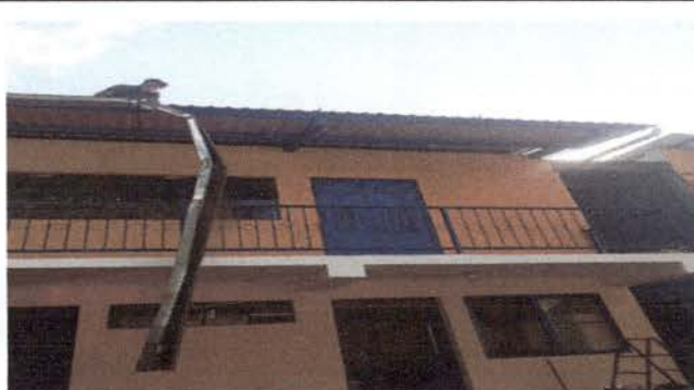
Foto 9: Retirando el canal en mal estado
