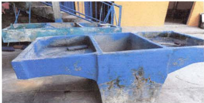
Foto 7: Retiro de pilas en mal estado
