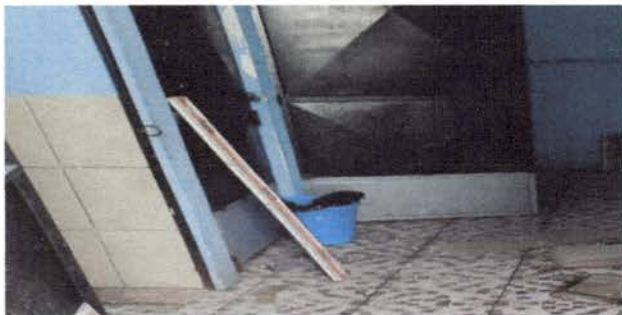
Foto 1: Reparación de puertas
