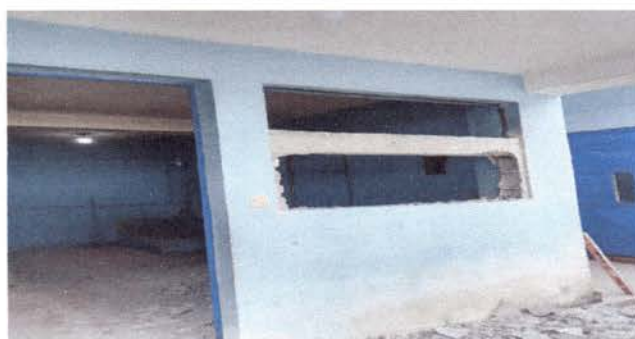
Foto 4: Corte de concreto para ventana
