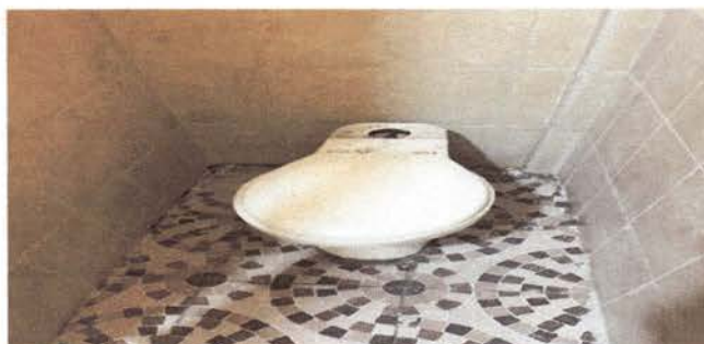
Foto 2: Cambio de Accesorios de sanitarios, piso
