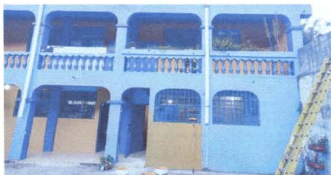
Foto 10: Corte de tubo de agua pluvial
