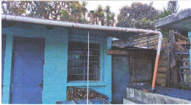
Foto 1: Fachada, cocina a intervenir y canal existente a la fecha
