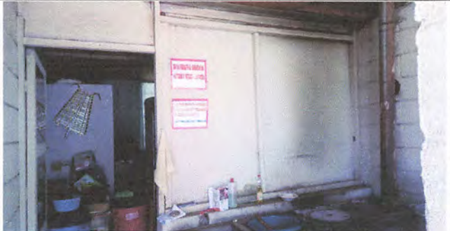
Foto 6: Interior cocina existente.
