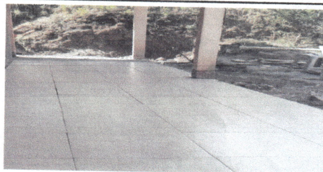
Foto 4: INSTALACION DE PISO EN CORREDOR.
