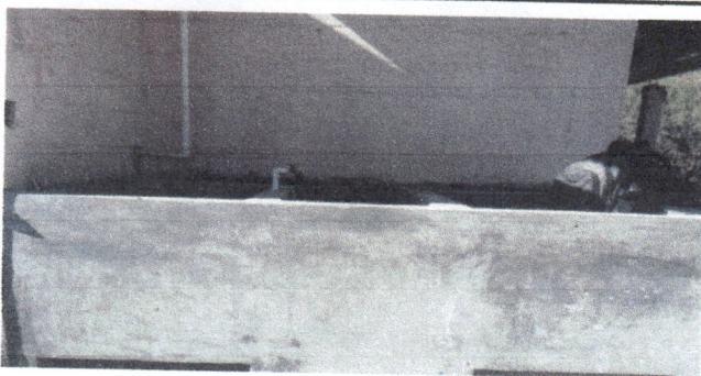
Foto 5: CONSTRUCCION DE PILA.
