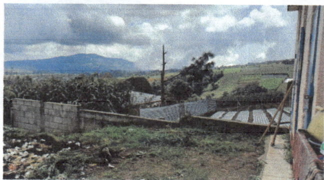
Foto 1: Área de muro a continuar
