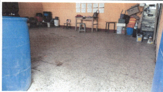
Foto 3: Sustitución de piso a cerámica en la cocina.
