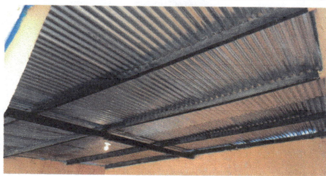
Foto 6: Ampliación en el sistema eléctrico.
