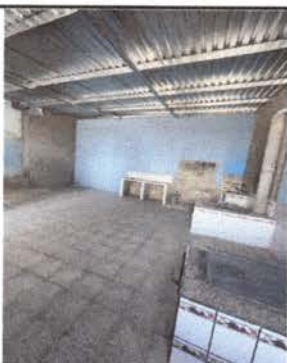
Foto 6: CAMBIO DE TECHADO
