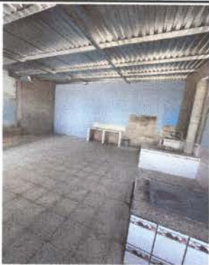
Foto 3: AMPLIACIÓN DE COCINA
