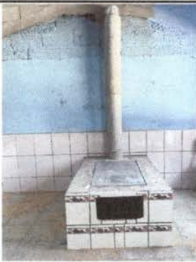
Foto 8: NUEVA PLANCHA DE METAL
