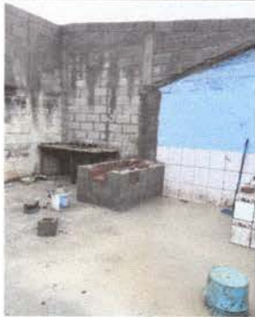
Foto 5: DEMOLICIÓN DEL MURO
