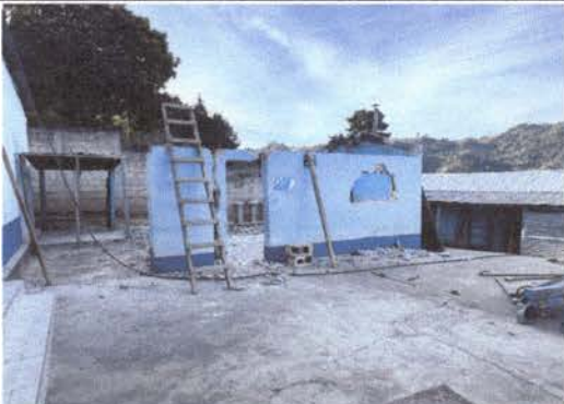
Foto 4: COCINA DURANTE LA CONSTRUCCIÓN
