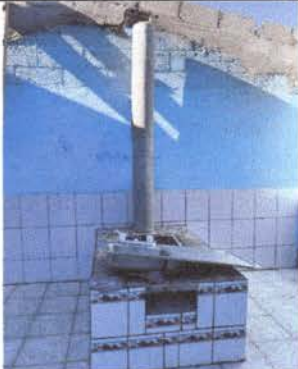
Foto 2: REMODELANDO EL POLLETÓN
