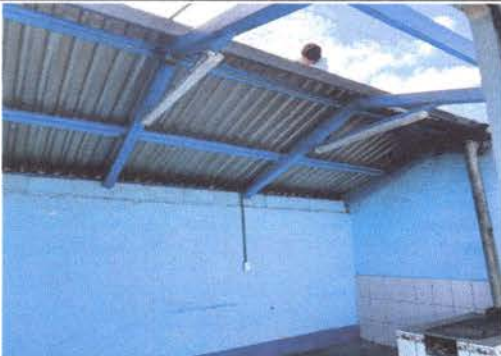
Foto 6: CAMBIO DE TECHADO
