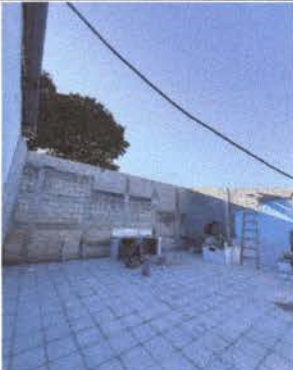
Foto 3: AMPLIACIÓN DE COCINA
