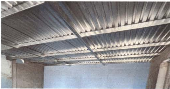
Foto 10: AMPLIACIÓN DE TECHO
