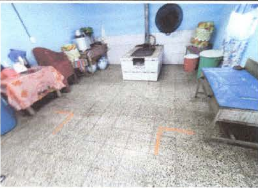
Foto 9: ÁREA DONDE SE AGREGARÁ MAS PISO
