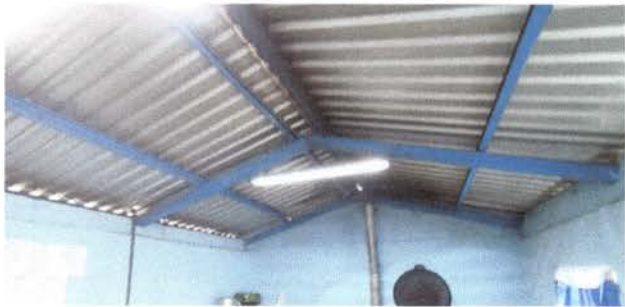
Foto 10: AMPLIACIÓN DE TECHO
