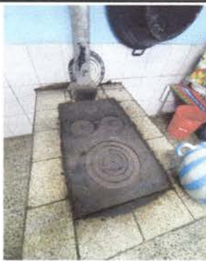
Foto 8: PLANCHA DE METAL CORROIDA
