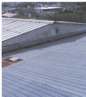
Foto 3: Por filtración de agua entre pared y canal se sella con lámina lisa
