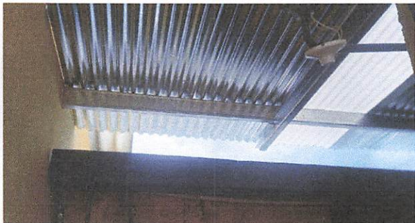
Foto 1: Cambio de techado de sanitario de niños y niñas
