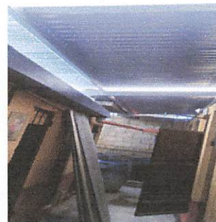
Foto 2: Colocación de techo con lamiluz sobre las pilas
