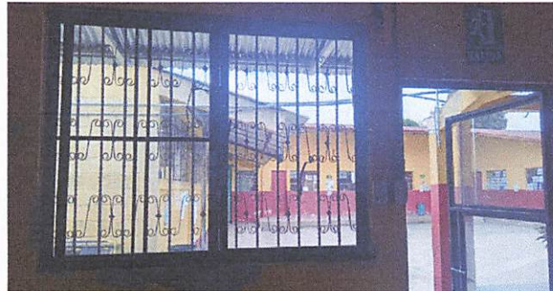
Foto 2: Ventanas corredizas con malla metálica
