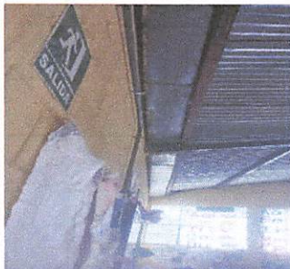
Foto 3: Por filtración de agua entre pared y canal se sella con lámina lisa
