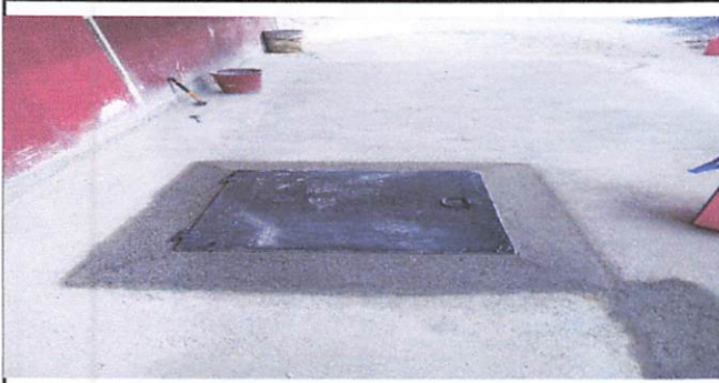
Foto1: Lugar Construcción del Cisterna
