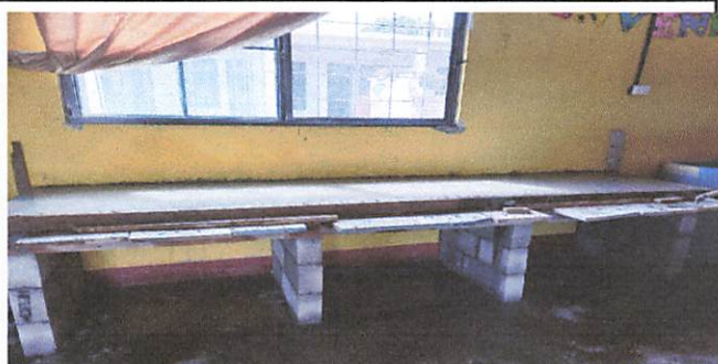
Foto 4: Construcción de la mesa de concreto de cocina
