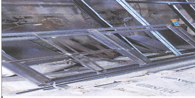
Foto 2: Ventanas corredizas con malla metálica
