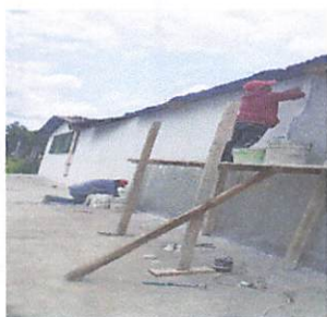
Foto 5: Repello y cernido de la pared de la calle
