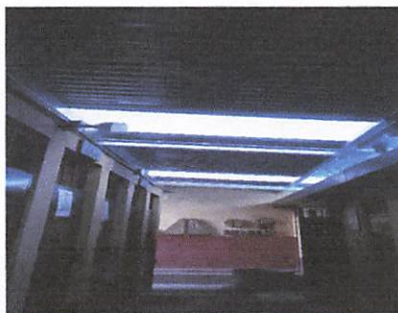
Foto 2: Colocación de techo con lamiluz sobre las pilas
