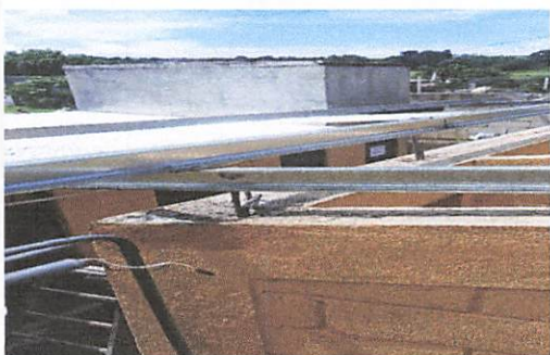
Foto1: Cambio de techado de sanitario de niños y niñas
