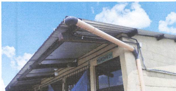
Foto 3: Cambio de canal de las aulas del patio No. 2
