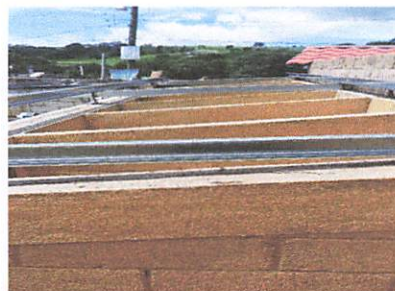
Foto 6: Techado de sanitarios
