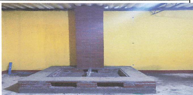
Foto 3: Construcción de poyo de cocina
