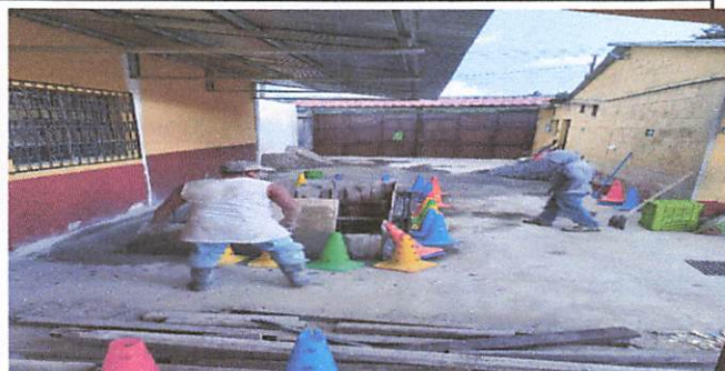
Foto1: Construcción del Cisterna
