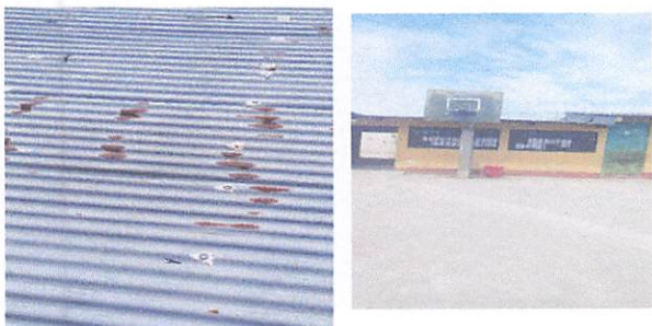
Foto 5: Reemplazar clavos y tornillos sin empaques en aulas y dirección
