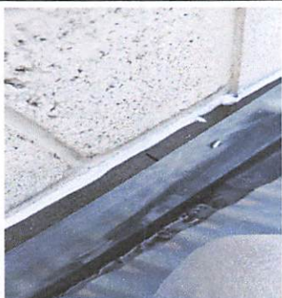
Foto 3: Por filtración de agua entre pared y canal se sella con lámina lisa
