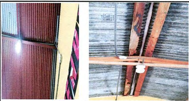
Foto 6: Cambio de clavos y tornillos en láminas
