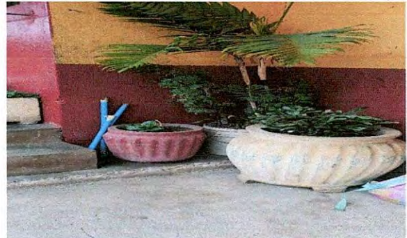
Foto 2: Lugar de la bomba del Cisterna
