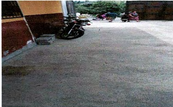
Foto1: Construcción del Cisterna
