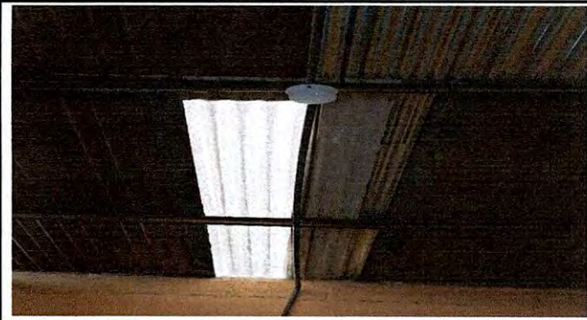
Foto 4: Por filtración de agua en la lámiluz se cambia por otra.
