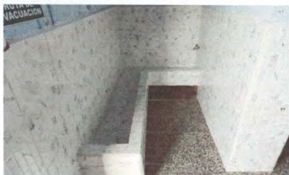
Foto 1: remodelacion de orinal en sanitarios varones 2m lineales 40 de ancho
