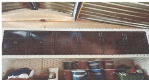
Foto 5: gavetero aereo en cocina 2.50 largo x 0.65 de fondo x 0.60 alto. Cimiento alto 1.75
