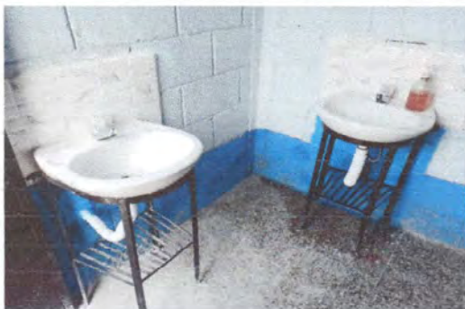
Foto 3: Cambio de lavamanos en sanitario de niñas
