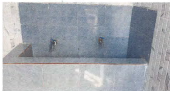
Foto 4: arreglo de chorros en lavamanos sanitario varones
