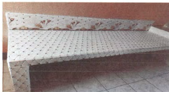
Foto 2: mesa de concreto en cocina
