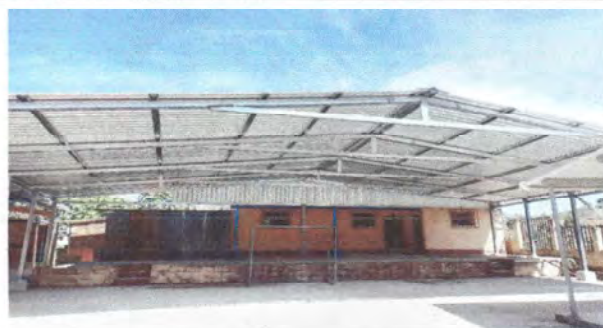
Foto 6: Sustitución de techado 130m2
