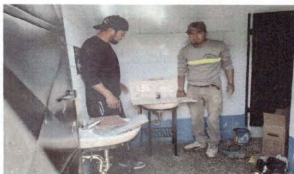
Foto 3: Cambio de lavamanos en sanitario de niñas
