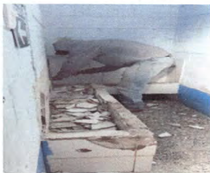
Foto 1: remodelacion de orinal en sanitarios varones 2m lineales 40 de ancho
