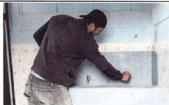
Foto 4: arreglo de chorros en lavamanos sanitario varones
