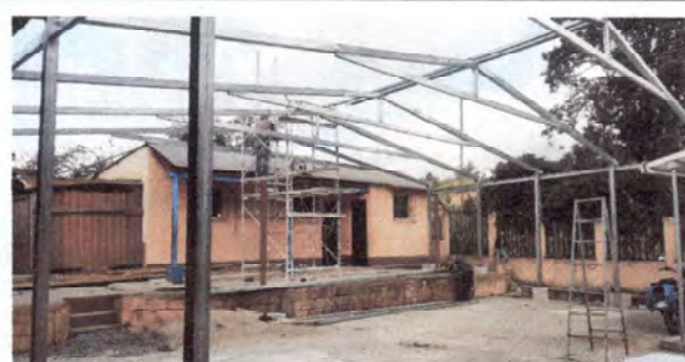
Foto 6: Sustitución de techado 130m2
