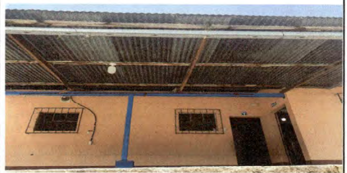
Foto 6: Sustitución de techado 130m2
