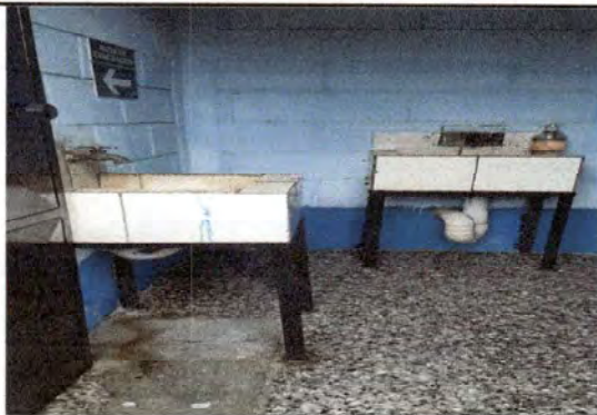
Foto 3: Cambio de lavamanos en sanitario de niñas
