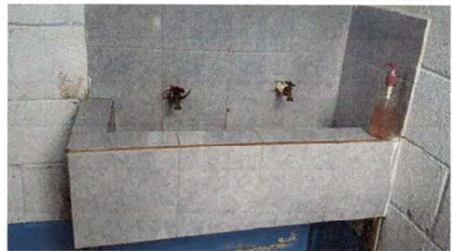
Foto 4: arreglo de chorros en lavamanos sanitario varones
