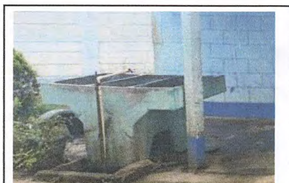
Foto 10: Cambio de pila y construcción de caja, cambio de tubo de cemento por tubo pvc de drenaje de la cocina.
