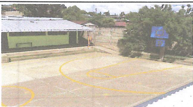
Foto 5: Reparación de los tablero
