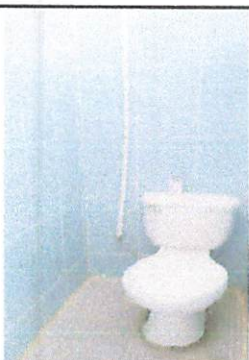
Foto 3: Trabajo finalizado del cambio de 8 sanitarios en el primer patio y conexión de agua en los respectivos tanques
