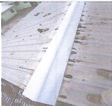
Foto1: Trabajo finalizado cambio de capote de 2 salones
