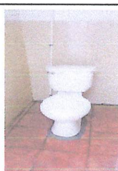
Foto 4: Trabajo finalizado del cambio de 4 sanitarios en el segundo patio y conexión de agua en sus respectivos tanques
