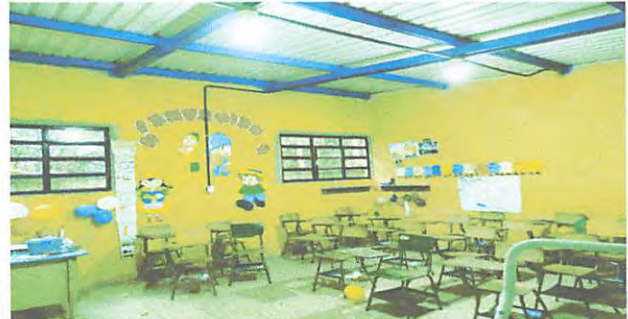
Foto 4: ILUMINACION EN AULAS
