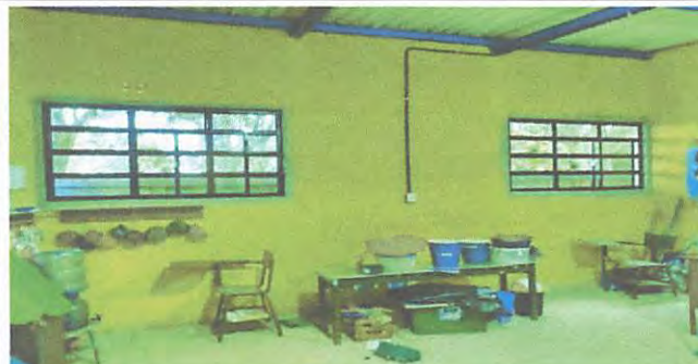
Foto 2. AULA 2 VENTANAS NUEVAS INSTALADAS
