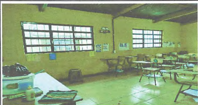
Foto 3: AULA 3 VENTANAS NUEVAS CORREDIZAS INSTALADAS
