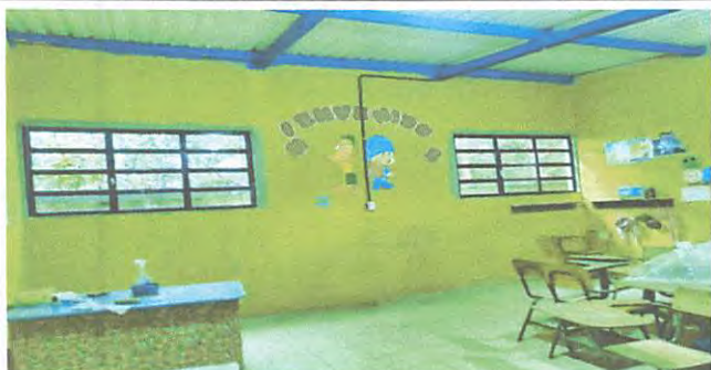
Foto1: AULAS 1 VENTANAS NUEVAS INSTALADAS
