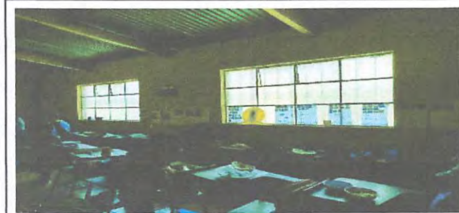
Foto 5: AULA 3 CAMBIO DE VENTANAS FIJAS A CORREDIZAS
