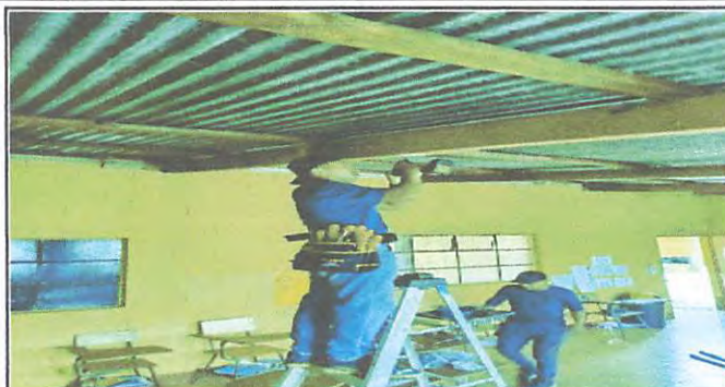
Foto 2: INICIO DE INSTALCION ELECTRICA NUEVA
