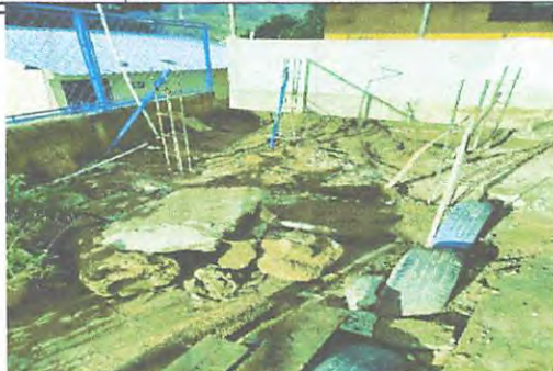
Foto1: INICIO DE CONSTRUCCION DE BASE PARA DEPOSITO
