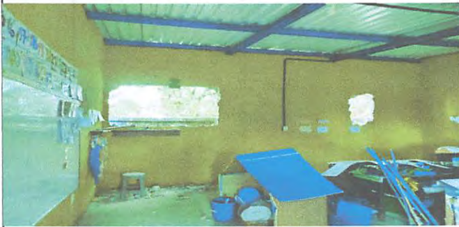
Foto1: AULA 1 PERFORACION DE PARED
