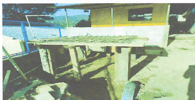
Foto 2: CONSTRUCCION DE BASE PARA DEPOSITO
