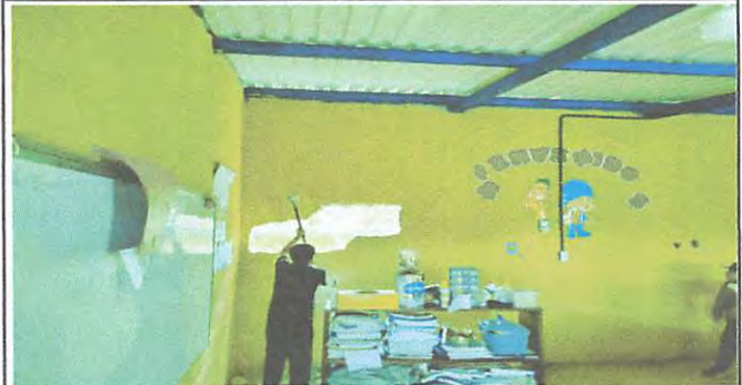
Foto 2. AULA 2 PERFORACION DE PARED
