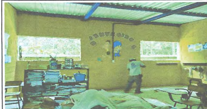
Foto 3: AULA 1 PARED YA PERFORADA PARA VENTANA
