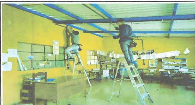
Foto 3: INSTALACION DE DUCTOS ELECTRICOS EN AULAS
