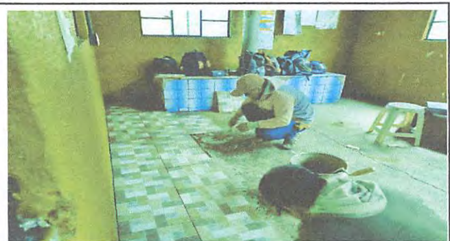
Foto 4: PISO INSTALADO EN COCINA
