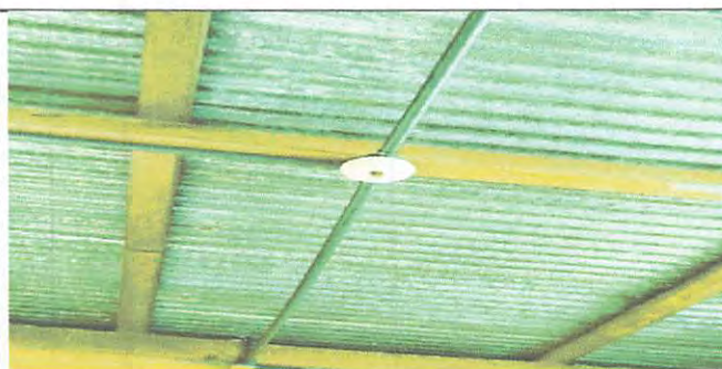
Foto 5: DUCTOS Y PLAFONERAS YA INSTALADAS
