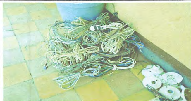
Foto1: ELIMINACION DE CABLES VIEJOS
