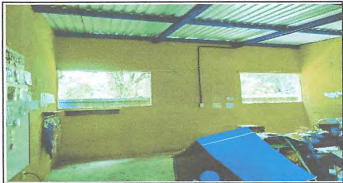
Foto 4: AULA 2 PARED YA PERFORADA PARA VENTANA
